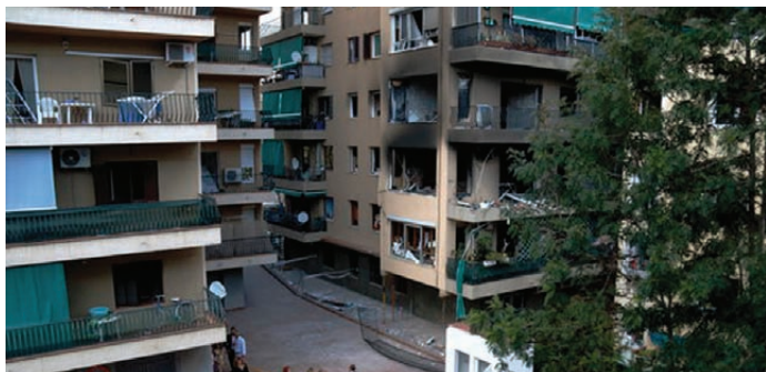
L'edifici sinistrat de Premià de Mar, en una imatge d'arxiu
