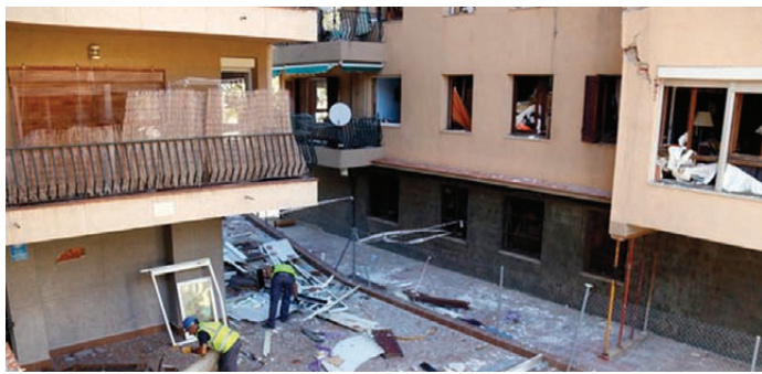
Estat en el que va quedar l'edifici sinistrat
