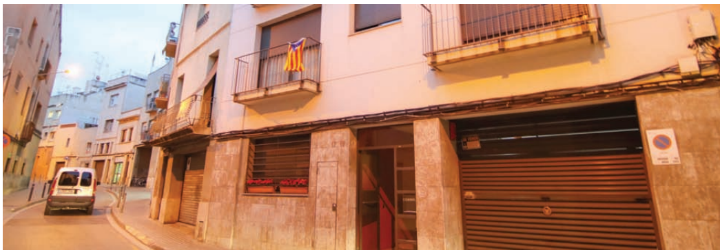
Una imatge de la façana de l'edifici.
