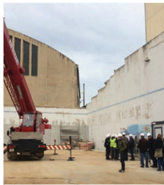
Les obres de la nova pista. Cedida
